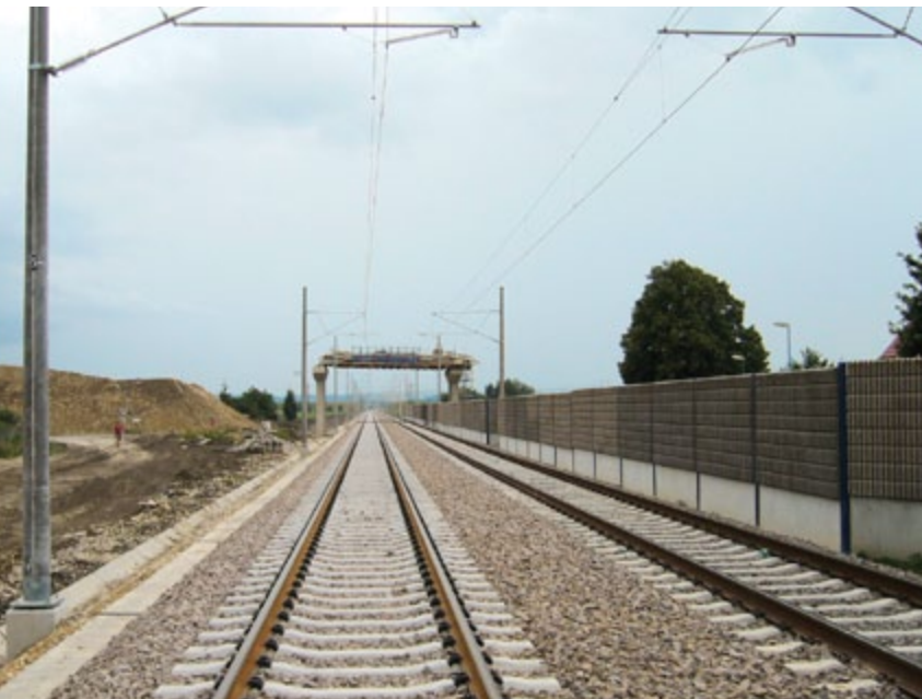
Výstavba cestného nadjazdu v Dubnici nad Váhom
