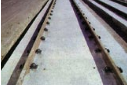
Kolaj po betonáži
