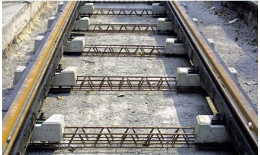
Rheda City pred betonážou
