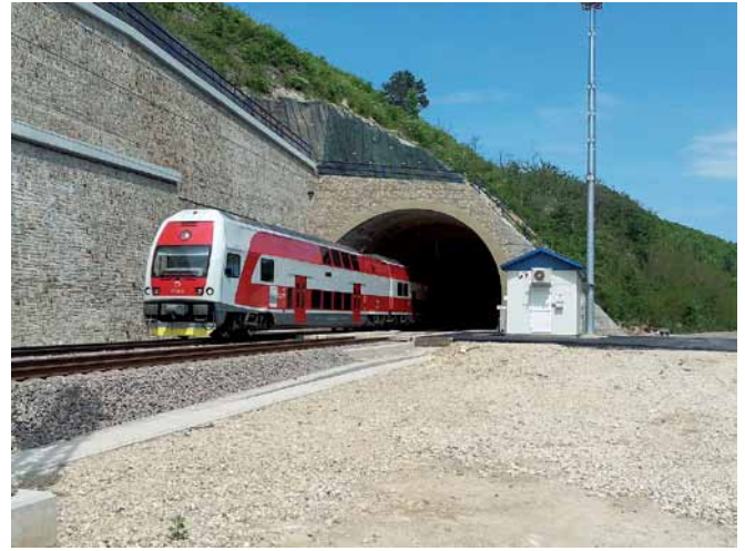
Turecký vrch – južný portál Turecký vrch – the southern portal
