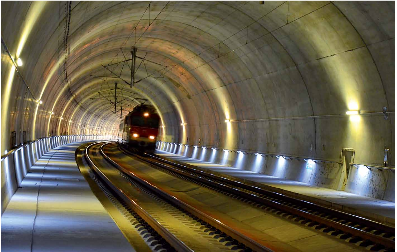
Tunel Turecký vrch v prevádzke Tunnel Turecký vrch during operation
