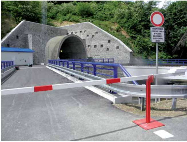
Turecký vrch – severný portál Turecký vrch – the northern portal
