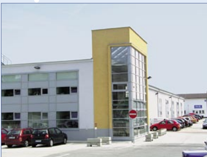
Rekonštrukcia haly Mikroplast
