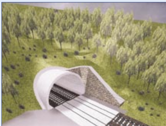
Jednorúrovňový dvojkolajný tunel cez prírodnú rezerváciu Turecký vrch
