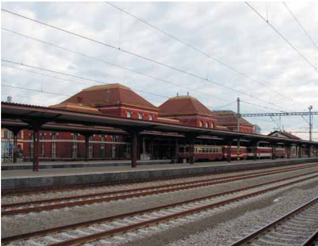
Modernizácia železničnej trate Trnava - Nové Mesto nad Váhom, žkm 47,55 - 100,5 pre traťovú rýchlosť do 160 km/hod (1. a 2., etapa)
