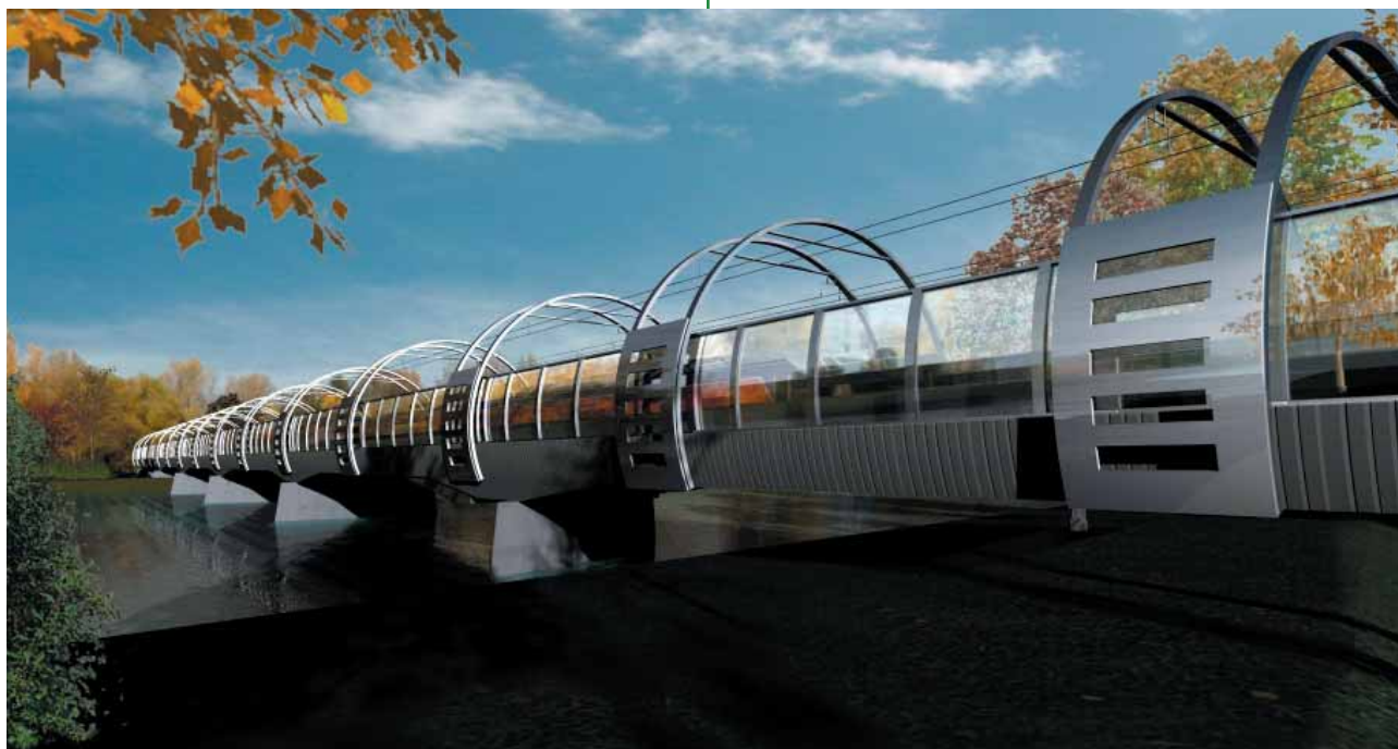
Železničný most v Trenčíne
