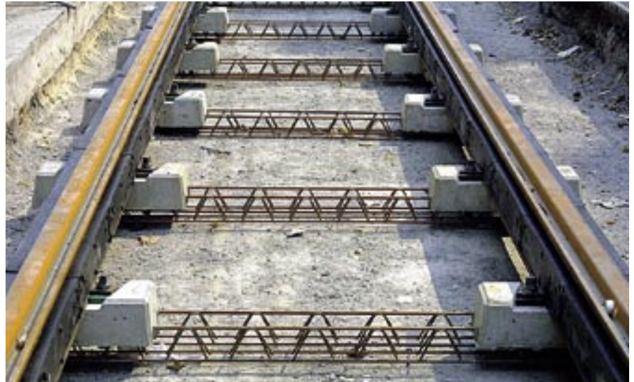
Rheda City pred betonážou
