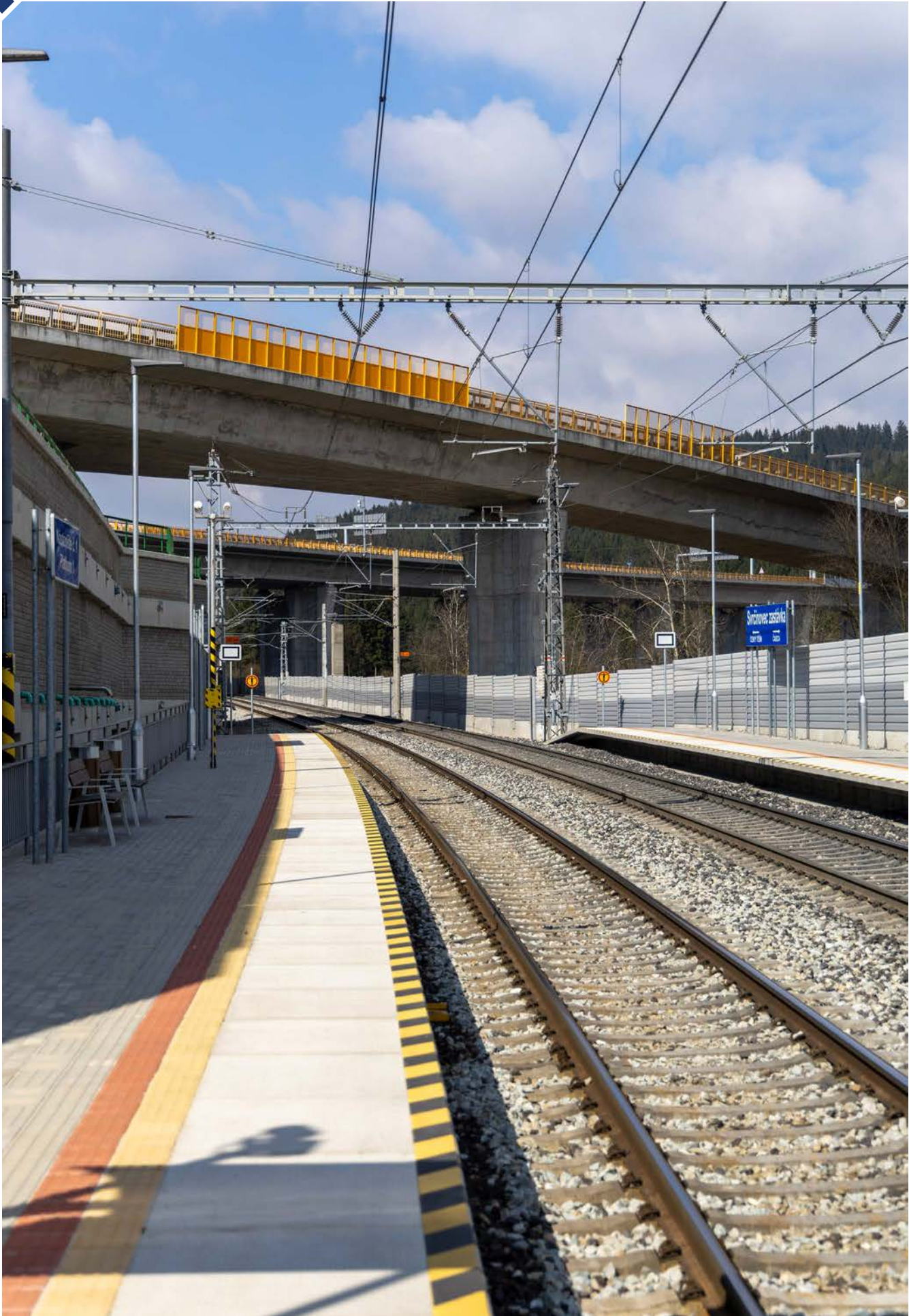
ŽSR, Modernizácia koridoru, štátna hranica ČR/SR - Čadca - Krásno nad Kysucou (mimo), železničná trať - 3. etapa, po zrealizovaní stavby, Investor ŽSR
