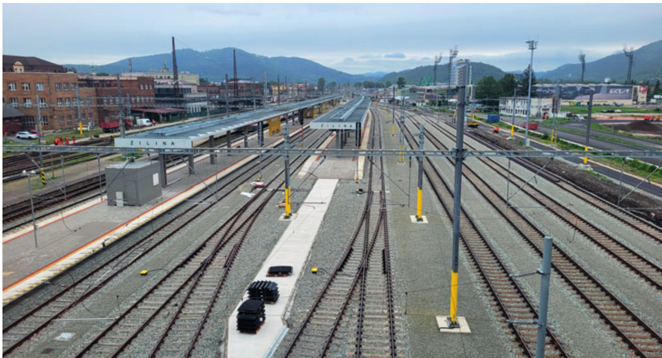
Obr. 8 Stav realizácie ŽST Žilina 06/2024
