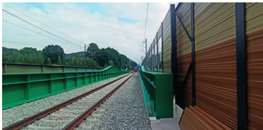
Obr. 6 Stav realizácie železničného mosta cez Váh 07/2024
