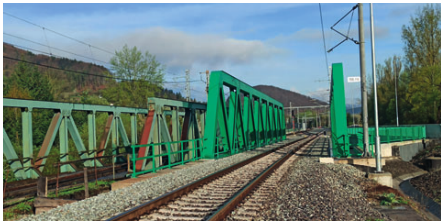
Obr. 4 Stav realizácie železničného mosta cez Rajčianku 03/2024
