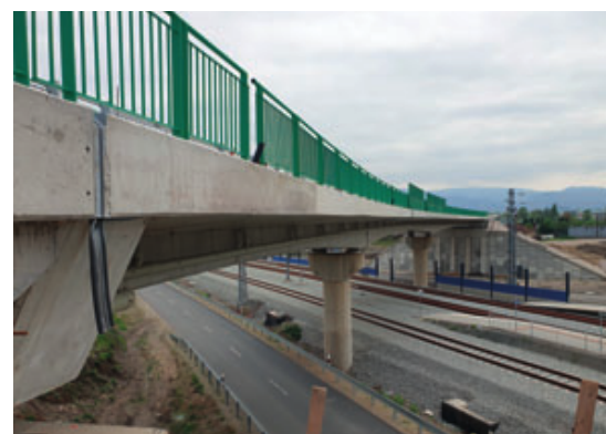
Obr. 5 Stav realizácie cestného nadjazdu 03/2024
