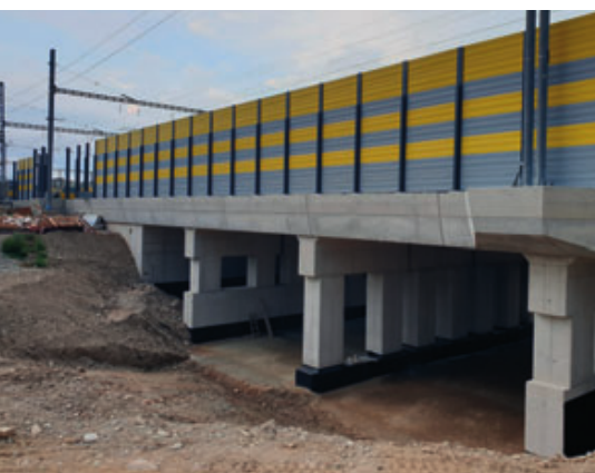
Obr. 7 Stav realizácie železničného mosta ponad ulicu Kysucká 07/2024
